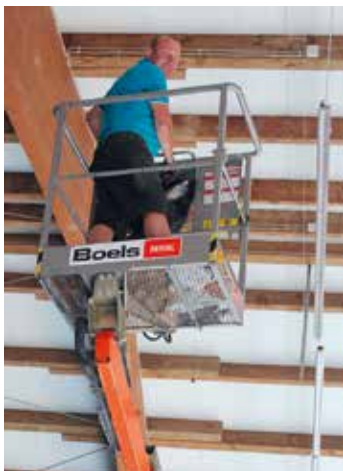
Montage unterm Hallendach: die neue LED-Anlage sorgt für helleres Licht und eine gleichmäßige Ausleuchtung der beiden Indoor-Tennisplätze
